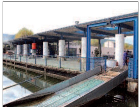
FOTO: Ajuntament de la Seu / Las obras del Parc Olímpic del Segre
